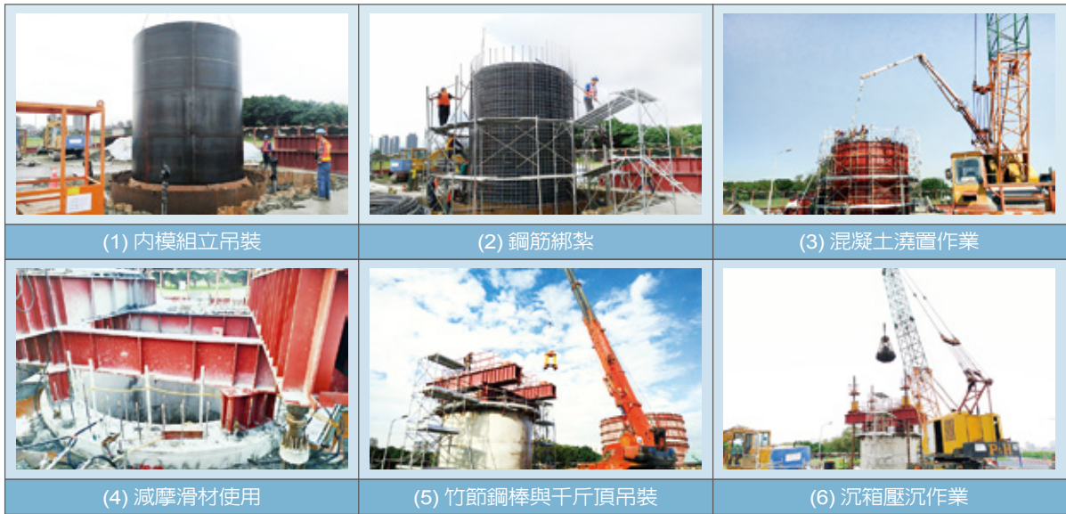
圖 7 沉箱構築壓沉作業
