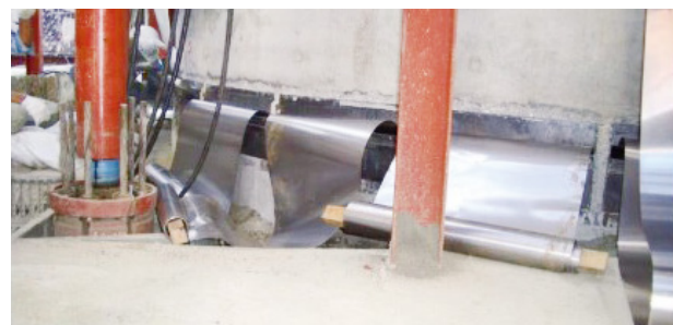
圖 2 減摩滑材 NF 膜示意圖
