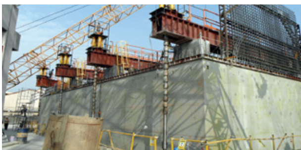
圖 1 壓沉沉箱示意圖
