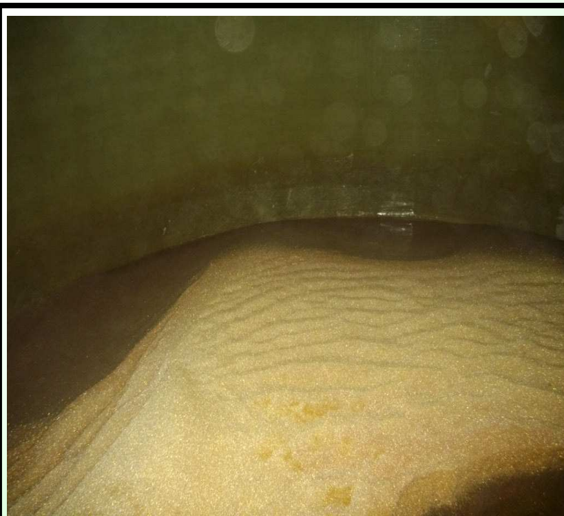
再生廢水儲槽發現樹脂流失
