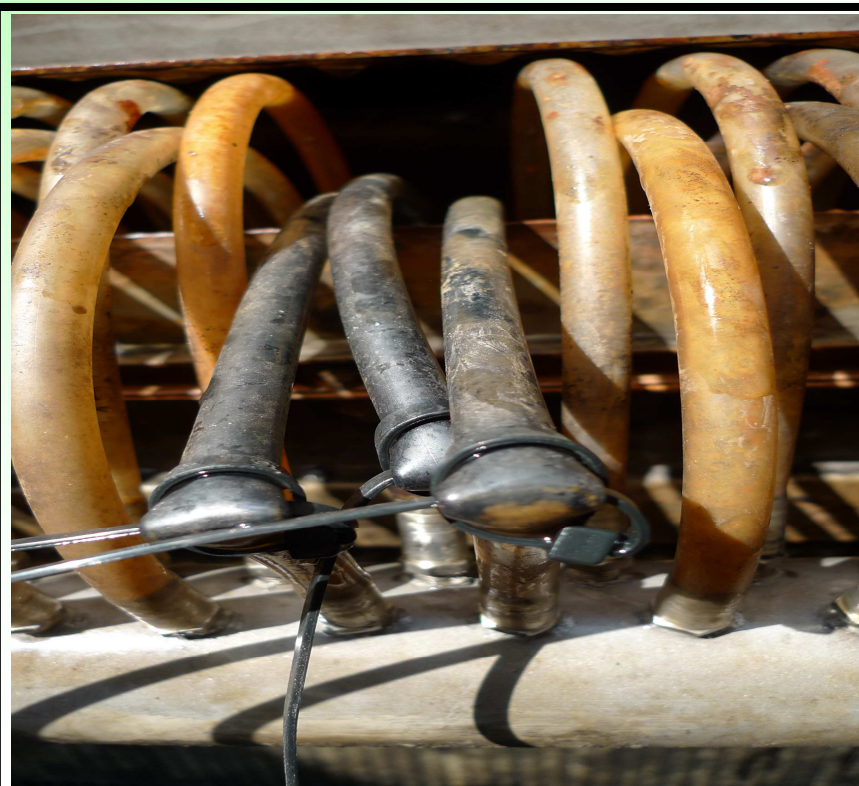
破損膜片產水管以束帶阻斷產水
